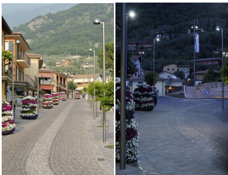
Fig. 29 – Corpo con ottica a LED da arredo urbano per strade secondarie con circolazione mista.
