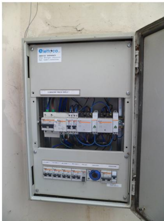
Fig. 10 – Il quadro montato all'interno dell'edificio scolastico
