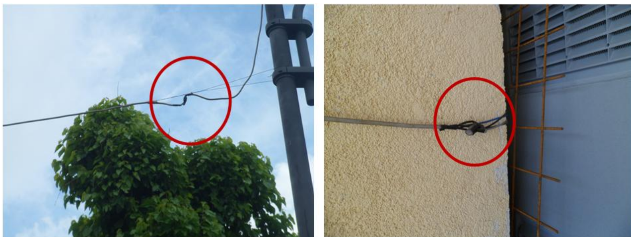
Fig. 21 – Situazioni critiche individuate per lo stato dei collegamenti elettrici
