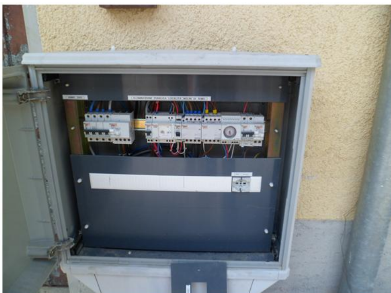
Fig. 15 – Il quadro in località Molini
