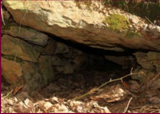
Due imbocchi di altrettanti cunicoli di attraversamento di strade o di avvallamenti del terreno, lungo la fiancata della montagna di Cemiglio, facenti parte del canale adduttore dell'acqua prelevata dal torrente Lavazzé, per irrigare i terreni delle "Ville di sotto". La loro fattura assai rudimentale, ci fa ritenere che essi potrebbero risalire alla fine del Settecento. (Foto d Ugo Fanti, 2014).
