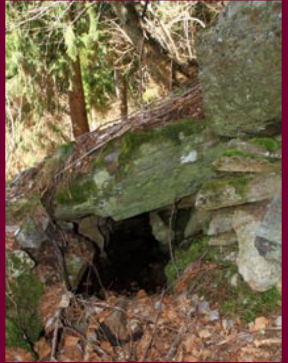
Due imbocchi di altrettanti cunicoli di attraversamento di strade o di avvallamenti del terreno, lungo la fiancata della montagna di Cemiglio, facenti parte del canale adduttore dell'acqua prelevata dal torrente Lavazzé, per irrigare i terreni delle "Ville di sotto". La loro fattura assai rudimentale, ci fa ritenere che essi potrebbero risalire alla fine del Settecento. (Foto d Ugo Fanti, 2014).
