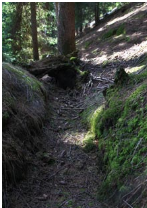
Un tronco del fosso scavato a mano lungo la fiancata della montagna di Cemiglio ed in uso fino ad alcuni decenni or sono, per portare l'acqua irrigua del torrente Lavazzé, dal punto di derivazione situato nei pressi del riparo denominato S. Antonio, fino alle campagne di pertinenza degli abitati di Marcena, Placeri, Mione, Ronco e Corte Inferiore. (Foto di Ugo Fanti, 2014).
